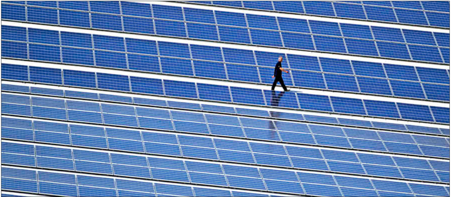
Mit Strom aus Sonnenenergie will der Gewerbepark Breisgau eine Vorreiterrolle in Sachen Klimaschutz einnehmen.
