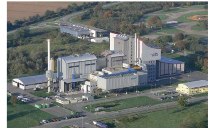
TREA Breisgau (Betreiber: EEW Energy from Waste Saarbrücken GmbH)
