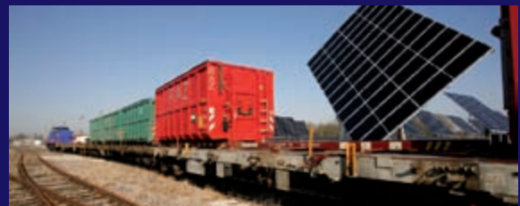
Solargleis im Gewerbepark Breisgau
