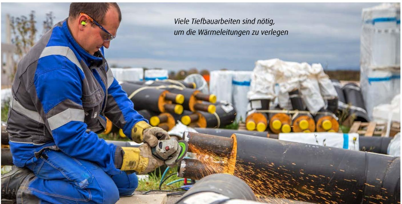
*Viele Tiefbauarbeiten sind nötig, um die Wärmeleitungen zu verlegen*
